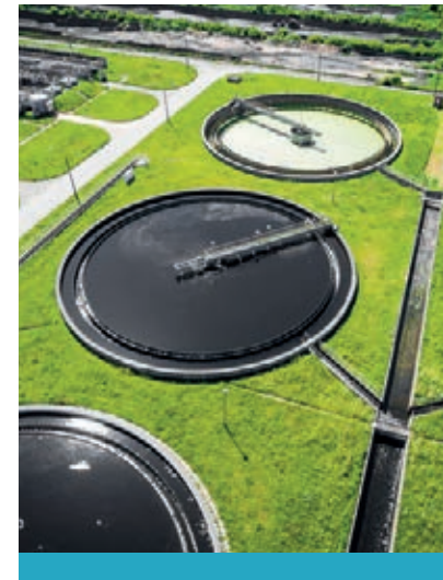
TRATAMIENTO DE AGUAS
